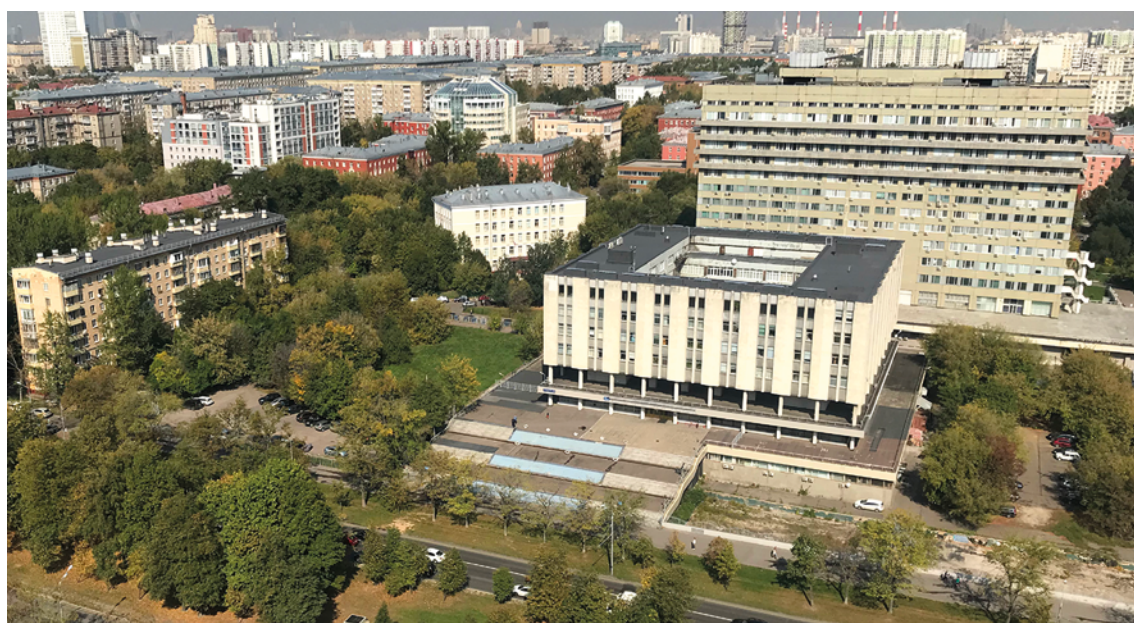
Рис. 13. Панорамный вид на существующее здание ИО РАН и прилегающую территорию, отведенную под строительство будущего нового здания
