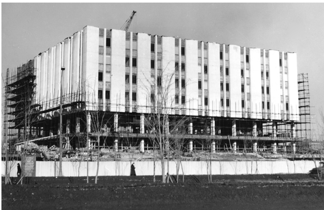
Рис. 8. Процесс строительства здания ИО РАН. Фотоархив ИО РАН
